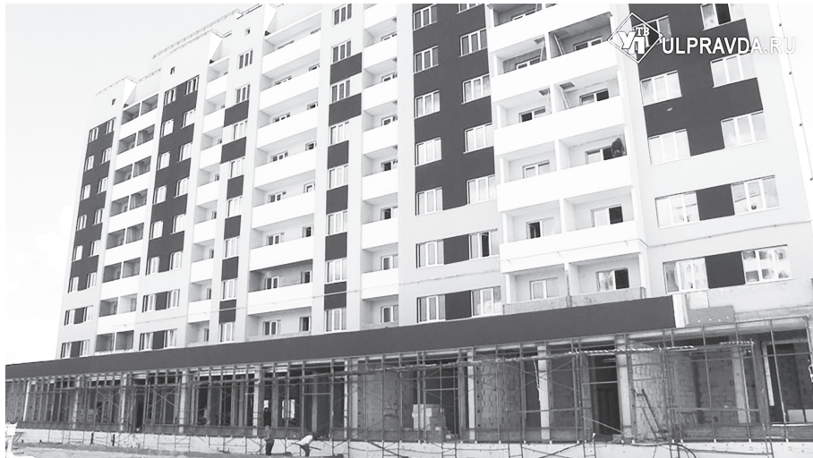
Дом № 31 в микрорайоне «Запад-1» находится на завершающем этапе сдачи. На следующей неделе в надзорный орган будут переданы документы, чтобы начать проверку и подготовку объекта к вводу в эксплуатацию.
